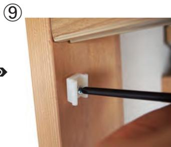
⑨ 付属の壁面固定パネル取付ブラケットを取付ける。壁面の3箇所ドライバーで付属のビスで取り付けして下さい。3箇所バランス良くお願いします。
