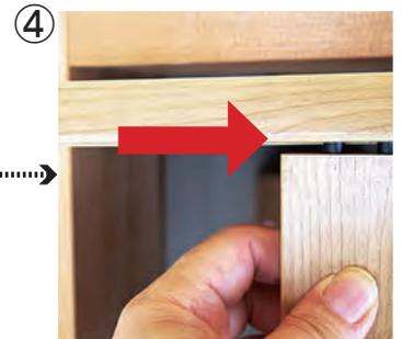
④ パネルドアを折り畳んでレールに差し込んで下さい。差し込む時は、ランナーが横を向かないように注意が必要です。差し込んだパネルドアはレールの中央(ビスの打っている箇所)に移動させて下さい。
