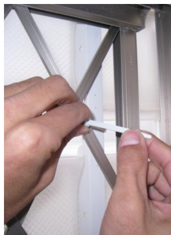
⑦差し込んだ先を引張り、軽く締め込みます。 ※一度に締めると製品が動く場合があります
