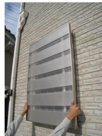
④室内側の人が取付バンドを固定するまで表側の人が押さえておきます (万一の落下予防)
