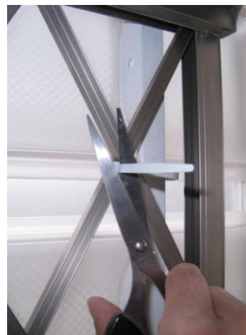
⑧ ⑤～⑦を繰り返すすべての箇所を仮止めした後、均等に本締めし、余分な部分をカットします。
