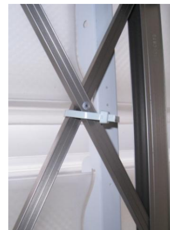
⑨取付完了
