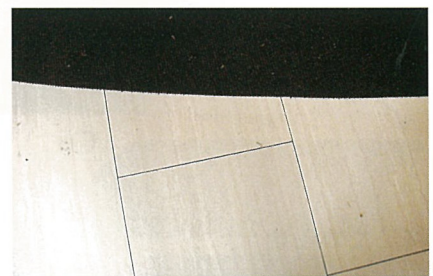
曲線部の切り口も写真のように、カッターで美しい仕上げが可能です。
