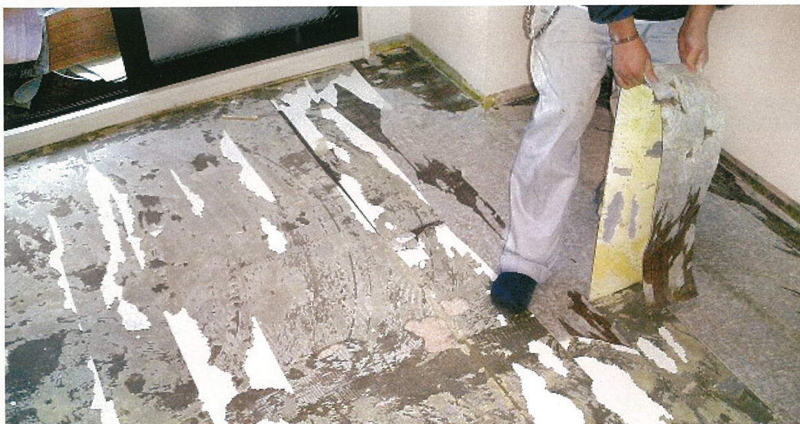
剥がし作業は大変な労力を伴う作業であり、また剥がした後の下地へのダメージも大きい。
